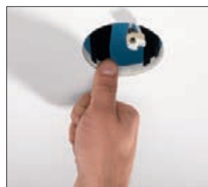
Haltehorn in die Gipskartonplatte eindrücken, um nachträgliches Verrutschen zu verhindern.
