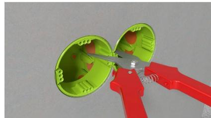
Bei Bedarf kann der SCS-Verbindungssteg ausgebrochen werden.
