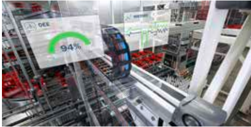
Produktionsanlage mit GAE-Überwachung
