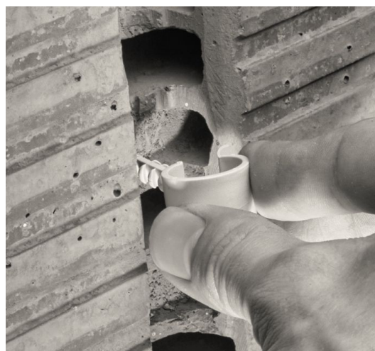
Einfach clever: Die integrierte Nase an der Innenseite der Schelle erlaubt das Spannen des Schlauches zwischen zwei Schellen - für einen leichteren Kabeleinzug.
