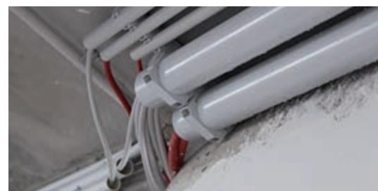
Durch das funktionelle Stecksystem werden mehrere EC Euro-Clips in unterschiedlichen Größen verbunden.
