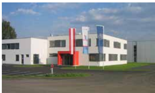
Zentrale in Kaindorf/Sulm
