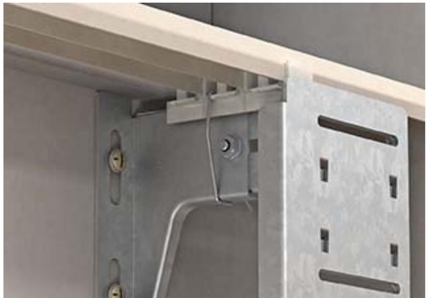
**Bild 7** Wandkonsole mit fertig montierten Konvektionsgitterprofilen
