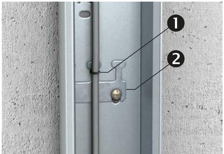
**Bild 20** Montage der Leitungshalter im LKM Kanal, vertikal
