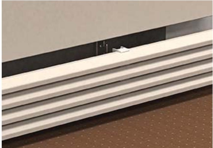
**Bild 14** Abdeckung des Panels im Bodenbereich mit Konvektionsgitterprofilen
