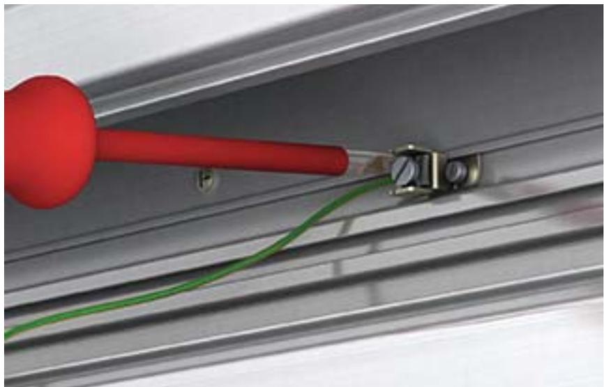
**Bild 48** Schutzleiteranschlusswinkel im GA Kanal
