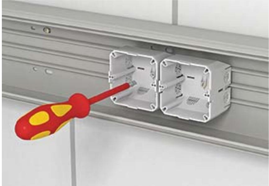
**Bild 38** *Montage der Geräteeinbaudosen auf dem Pilzprofil*
