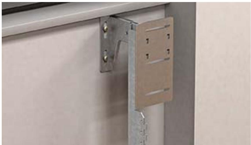
**Bild 8** Montage- und Verbindungsprofil auf Wandkonsole
